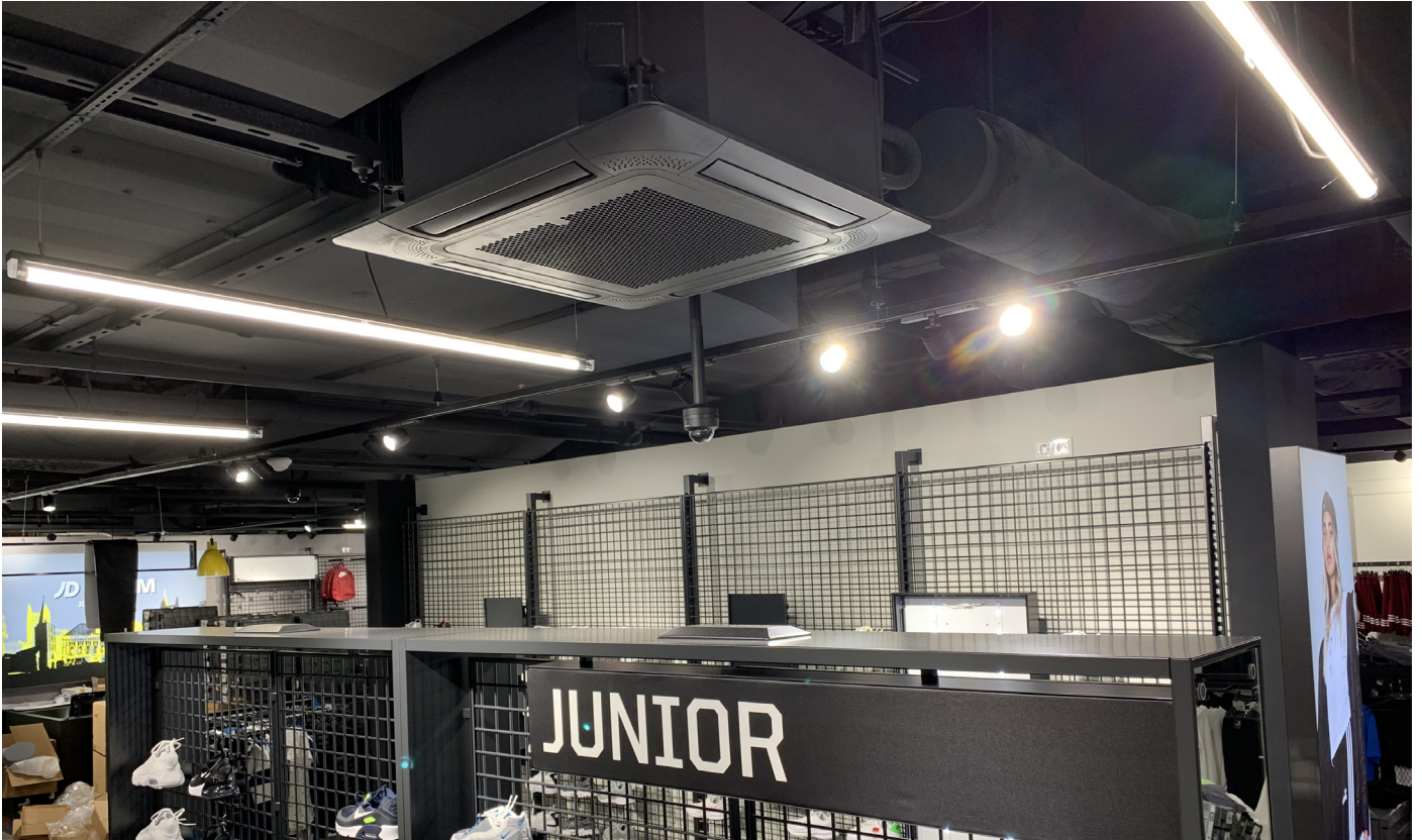
Installation der Kassettengeräte im Eurorastermaß
